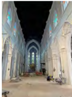
鹰架都已拆除，现正进行灯光和风扇的安装工作
