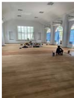
北边楼的大厅现正进行铺地砖工作
