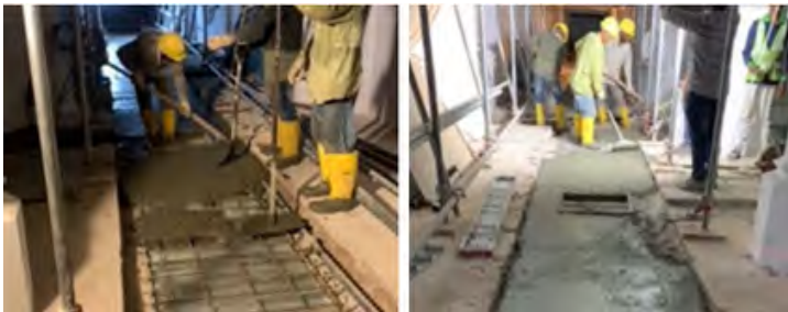
沟槽浇筑工程
