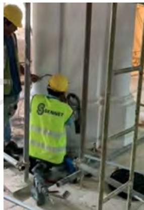
大堂区域的机电布线工程
