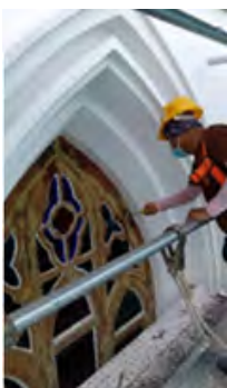
涂上木材防腐剂
