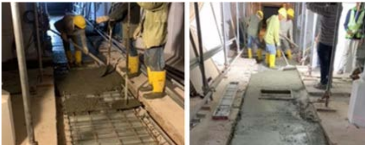
沟槽浇筑工程
