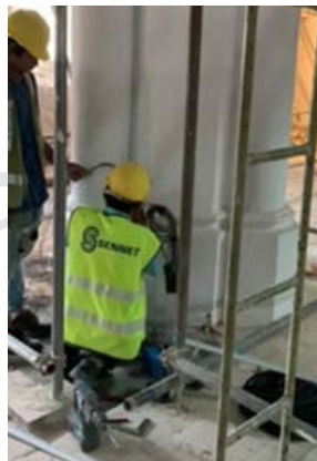
大堂区域的机电布线工程
