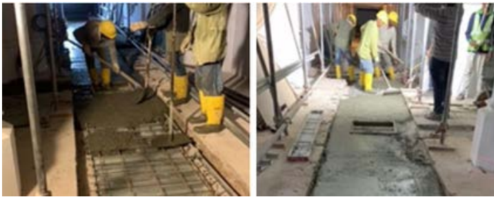
沟槽浇筑工程
