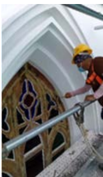
涂上木材防腐剂
