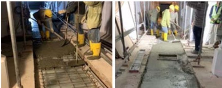
沟槽浇筑工程
