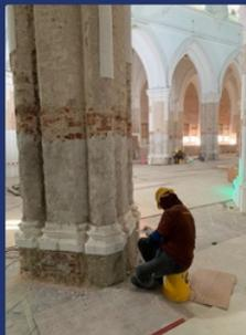
在大堂内部，剔除南侧和西侧大面积空心部位灰泥的工作亦接近完成。而在北侧这方面的工程将于下周开始。拆除外表防护后，北侧将进行系列防潮、杀虫和盐化处理。不需要剔除灰泥的地方也在进行清除表面喷涂的工作。
