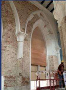
外围脚手架的搭建几近完成，基本上已经延伸到了建筑南端，预计将在两周内覆盖到建筑东侧。东侧外墙的喷涂清除工作已经开始，凡空心部位抹灰的清除工作也将于下周展开。对建筑北侧阳台立面雕饰上的不同喷涂层作了特别的处理。这将有助于既保持雕饰的原本颜色，也使艺术品得以恰当的保护。
