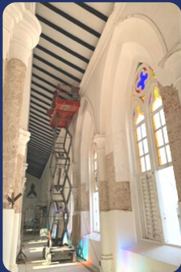
脚手架已经在建筑物东北部一侧搭建完成，预计两周后西北部一侧（西侧门廊）的脚手架也将搭建完。而在大堂内部，沿着立柱和内墙自下往上约2米范围，墙柱内部有空心部位的洋灰已近清除完毕。自穹顶底部至高处的空心部位也正在作表面标记。
