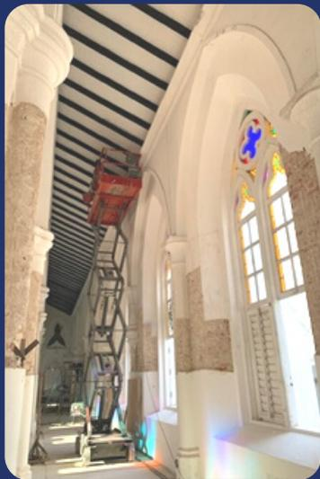
脚手架已经在建筑物东北部一侧搭建完成，预计两周后西北部一侧（西侧门廊）的脚手架也将搭建完。而在大堂内部，沿着立柱和内墙自下往上约2米范围，墙柱内部有空心部位的洋灰已近清楚完毕。自穹顶底部至高处的空心部位也正在作表面标记。
